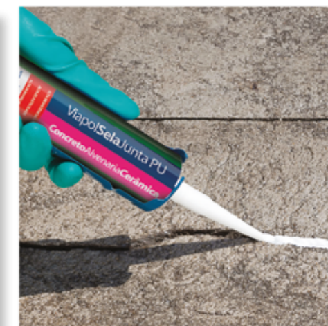
Selantes e Reforço de Borda
